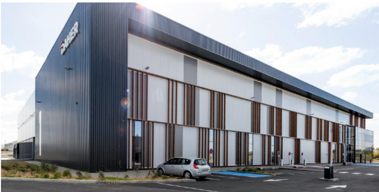
DAHER | Toulouse (31) | 20 000 m 2 Construction d'un site industriel aéronautique
