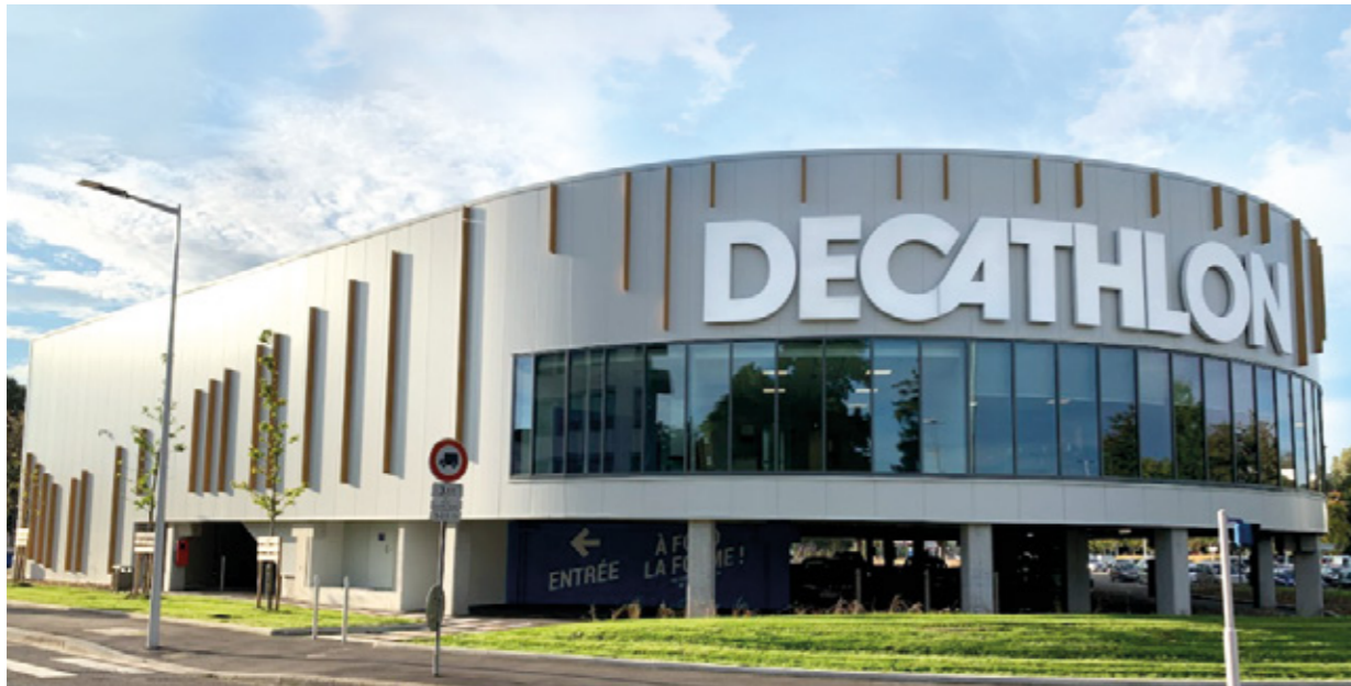
DECATHLON | Bourg-en-Bresse (01) | 3 800 m 2 | Réalisation d'un espace commercial
