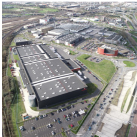
PILOTAGE DES TRAVAUX
