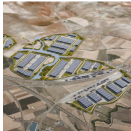
MONTAGE ET RÉALISATION D'OPÉRATIONS
