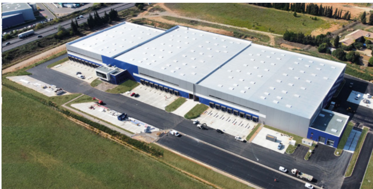
BERT & YOU | Saint-Gilles-du-Gard (30) | 20 000 m 2 Conception et construction d'une plateforme logistique
