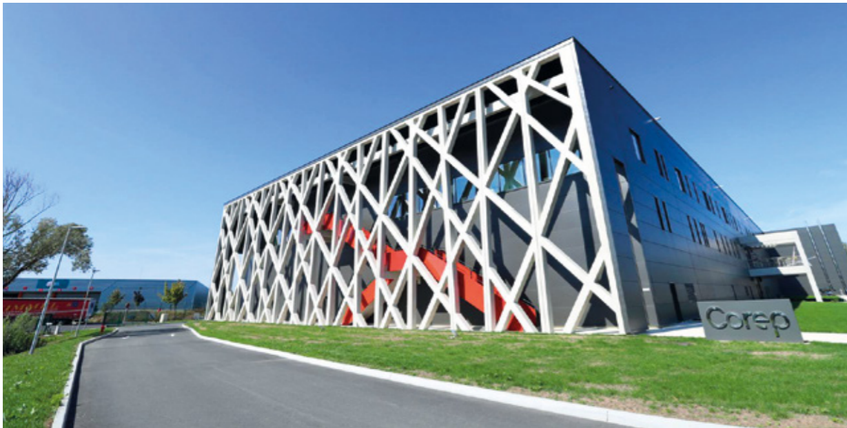
COREP | Bègles (33) | 30 000 m 2 Construction d'un site industriel & showroom de luminaires
