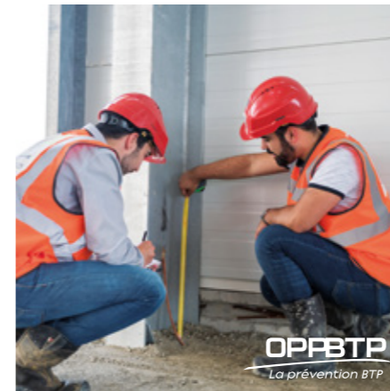
DES MESURES CONCRÈTES APPUYÉES PAR UN PARTENARIAT AVEC L'OPBTP
