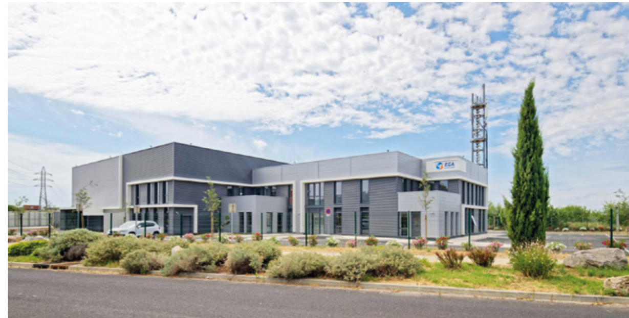
ECA ROBOTICS | Montpellier (34) | 2 375 m 2 Construction d'un site industriel de robotique
