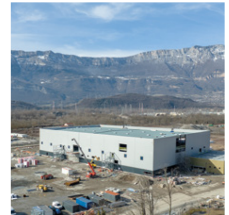
GESTION RESPONSABLE DES DÉCHETS SUR CHANTIER
